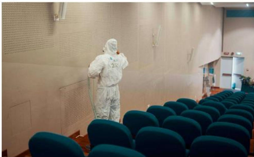
Un'immagine dei lavori di sanificazione eseguiti all'Istituto Gonzaga di via Vitruvio
